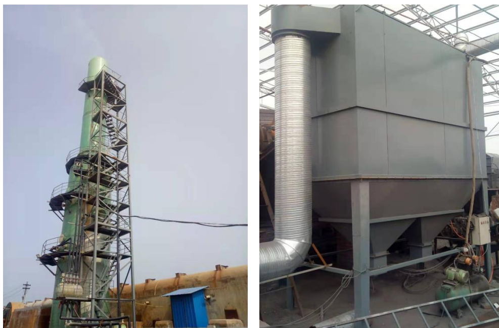
隧道窑脱硫除尘设施及粉碎车间除尘设施照片
