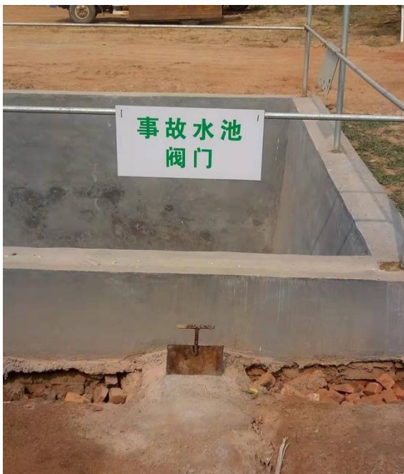
事故池及雨水口切换阀
